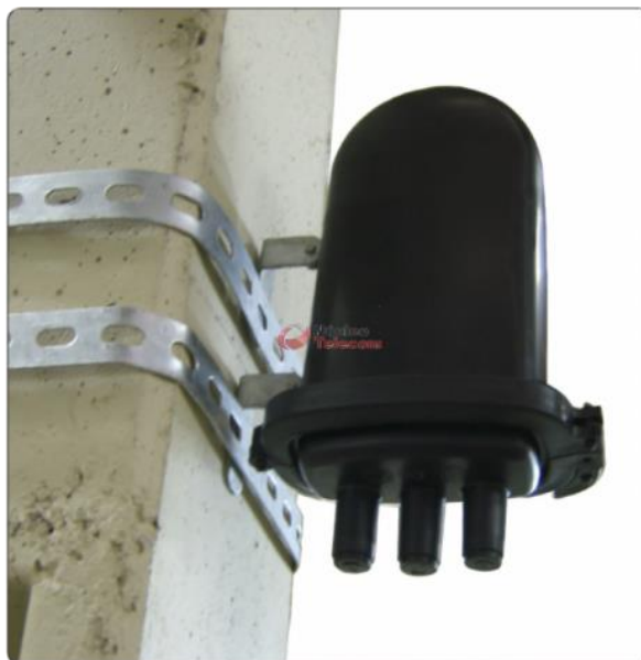
Figura 5.9 – Exemplo da Caixa de Emenda Óptica.
